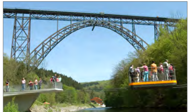
Abbildung 8: Müngstener Brücke mit Schwebefähre – Wahrzeichen für Solingen und das Bergische Städtedreieck
